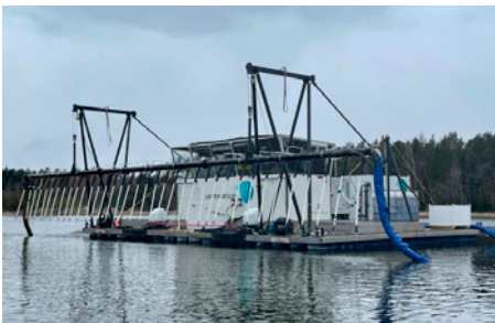
Aluminiumlösningen förs ner till bottensedimentet från en så kallad läggare. Foto: : Lisa Bergqvist/Stockholms universitets Östersjöcentrum
